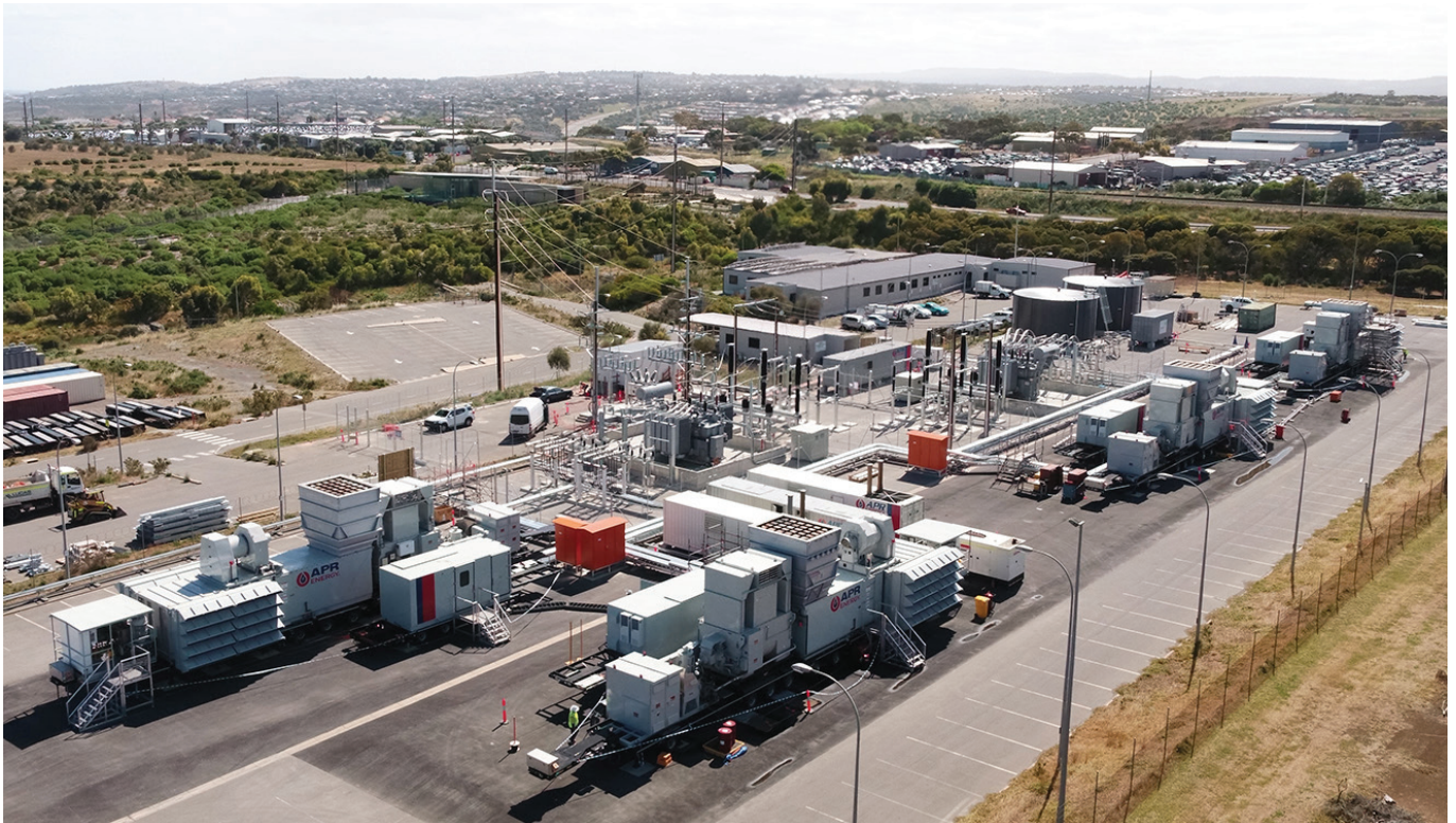
TG Sur central eléctrica, Adelaide, A.M
