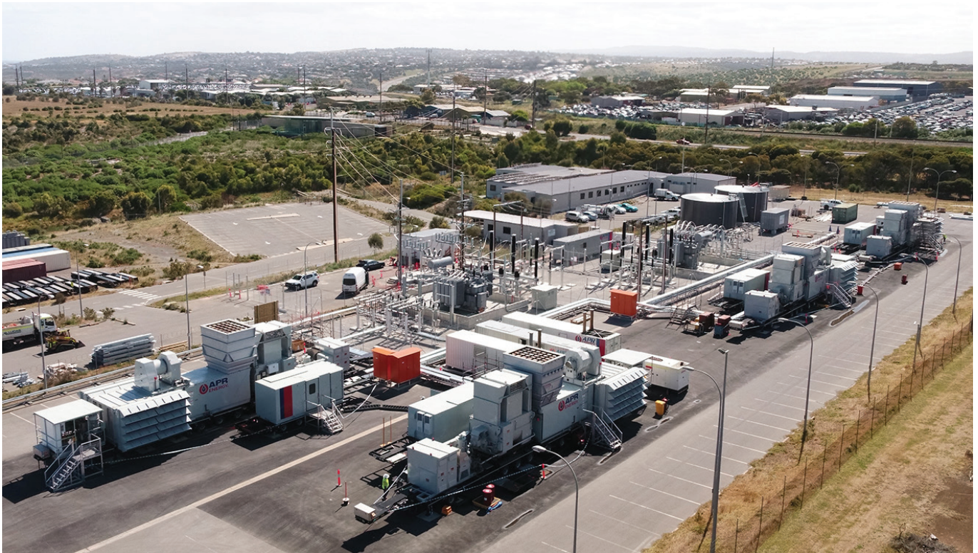
TG Sur central eléctrica, Adelaide, A.M
